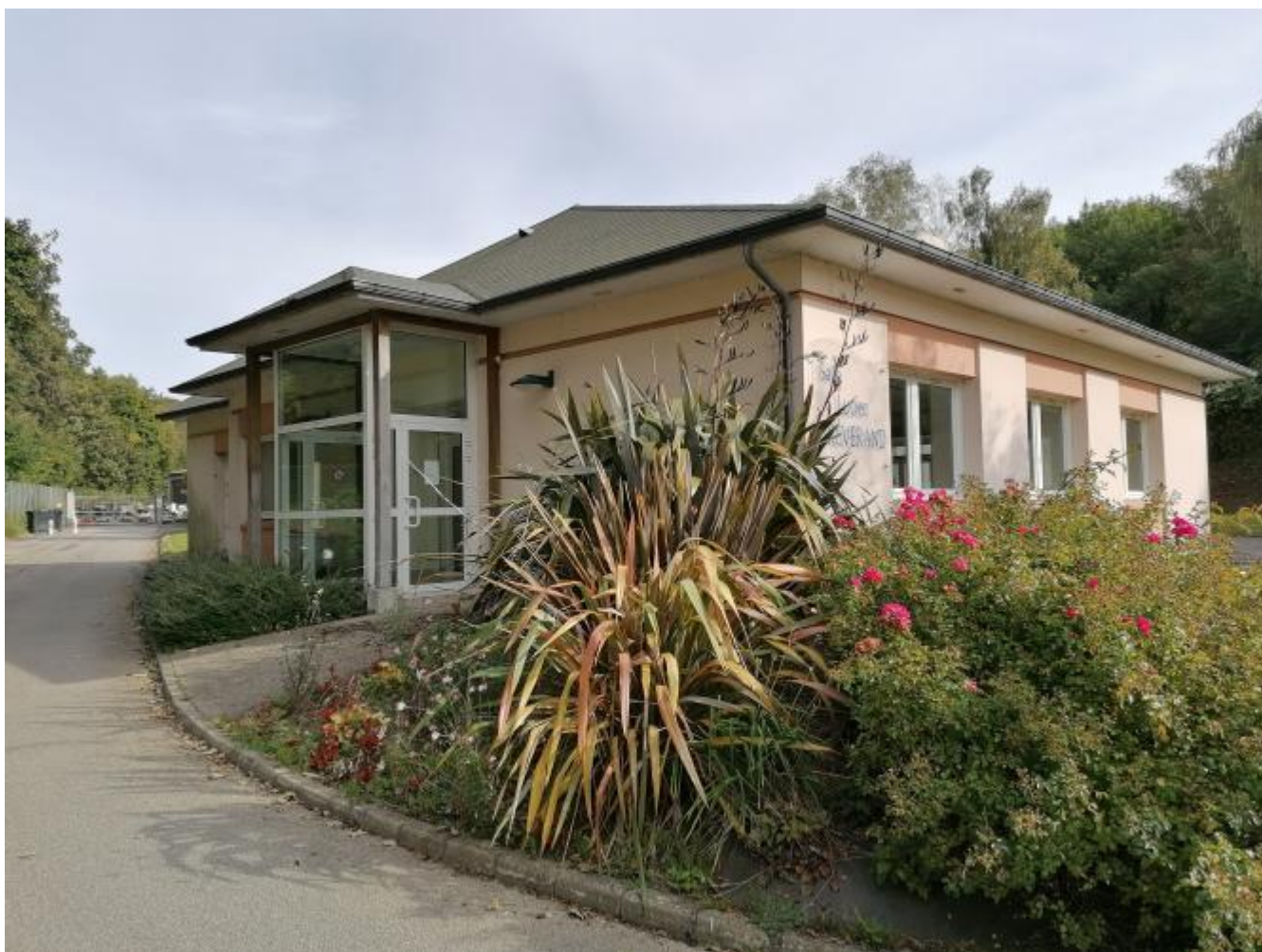
Salle du Mognan @ÉLUSFONTAINELAMALLET
